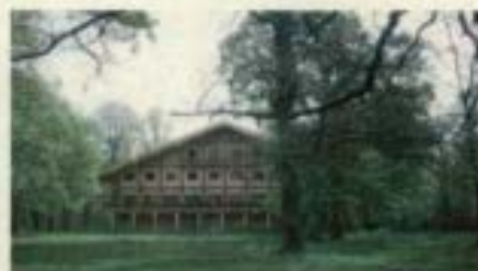
Albergue de Espinosa, construido en el Robledal (Monte Edilla).
